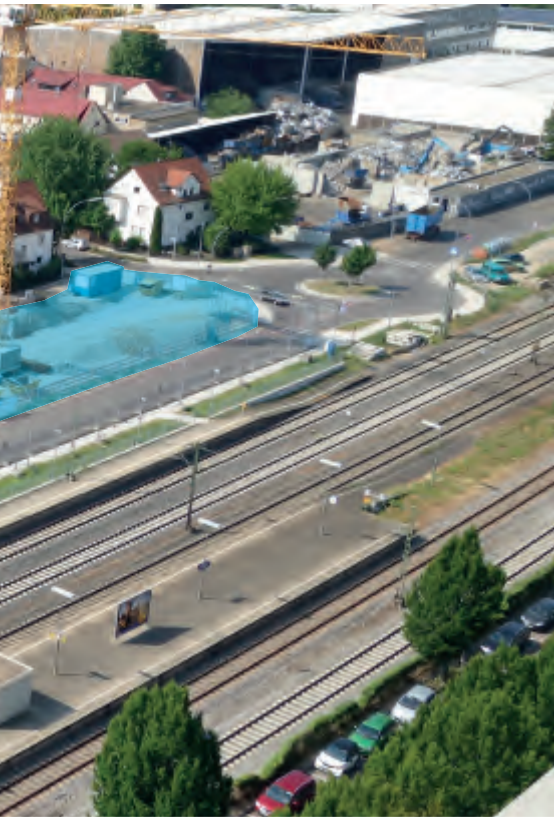
Direkt am Bahnhof Fellbach (im Bild links unten) entsteht auf einer früheren Straßenfläche das neue Wohn- und Geschäftshaus.
